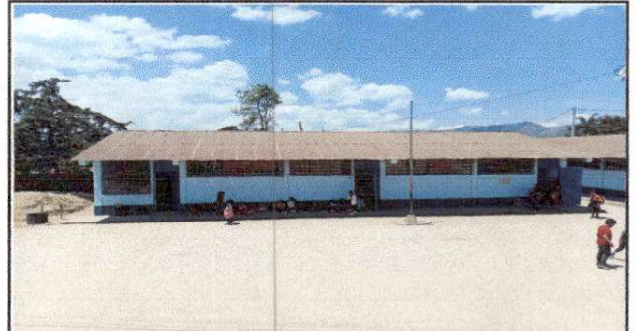
Foto 2: Sustrucción de lamina, por lamina troquelada aluzinc calibre 26
