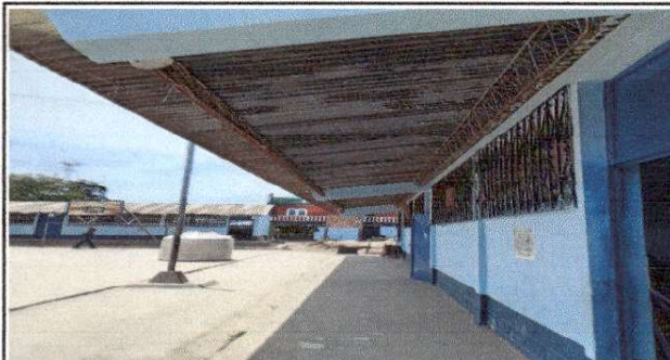
Foto 3: Sustrucción de elementos de fijación, pernos de 14 pulgadas
